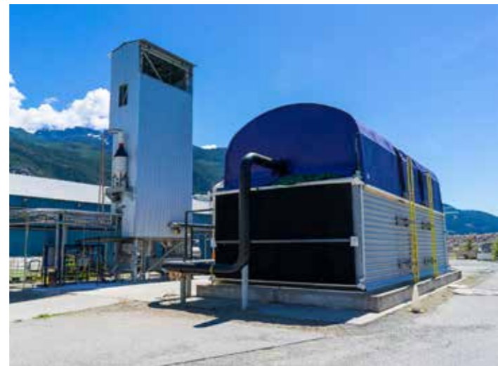
Carbon Engineering社の直接空気回収システムエア・コンタクターとか焼炉(左) 写真提供: Carbon Engineering Ltd
