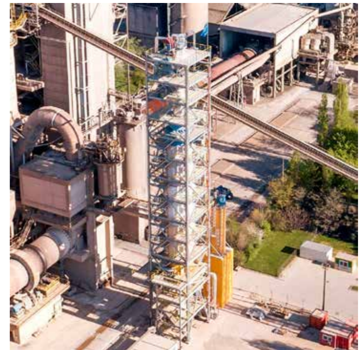
ベルギーのLEILAC/パイロット工場におけるCalix高品質焼成反応炉 写真提供: Calix
